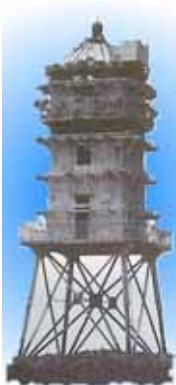
Turm 10: Eversand Unterfeuer , der Kormoran-Turm
